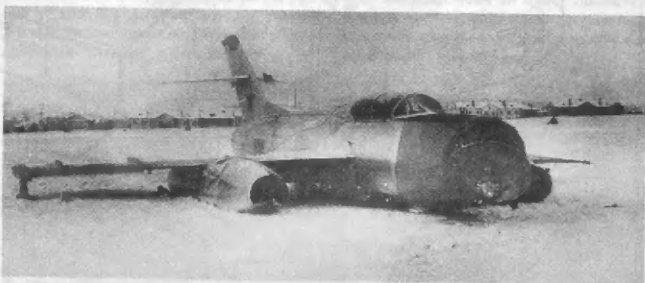
Перехватчик Як-27. Вынужденная посадка летчика А. И. Гришина 31.01.1958. Видна антенна РЛС «Сокол-2».
